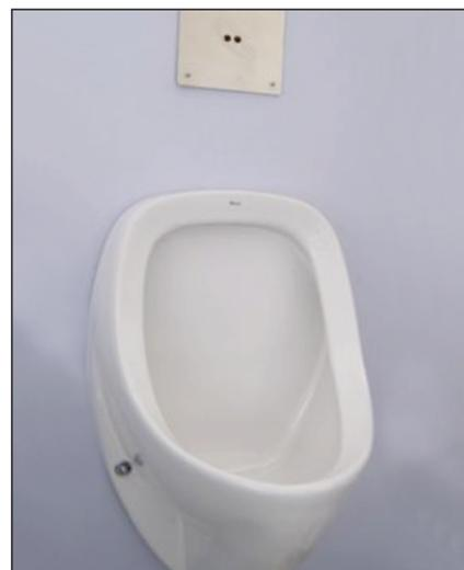
Vista da instalação final da louça de mictório em conjunto com a válvula sensorizada de embutir.
