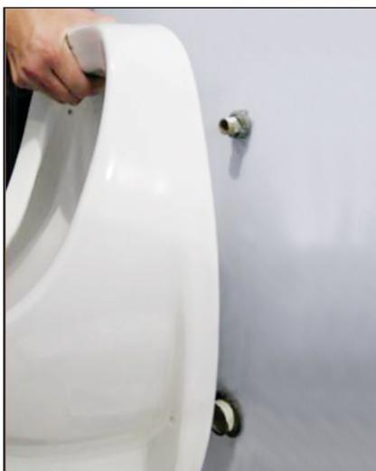
Fixando a louça de mictório, ao apertar os parafusos, a pressão faz com que a massa de calafetar sirva de anel de vedação.
